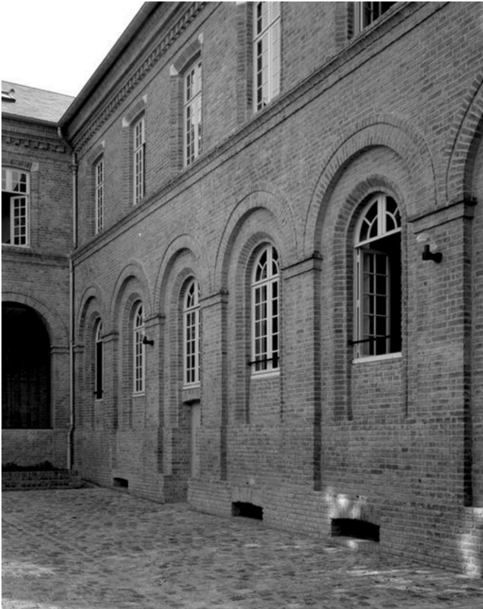
Façades sur la cour dite des Provisions, en 1983. Ancien cloître (rez-de-chaussée), bibliothèque, archives et dortoir (étage) devenus salles de classe.
