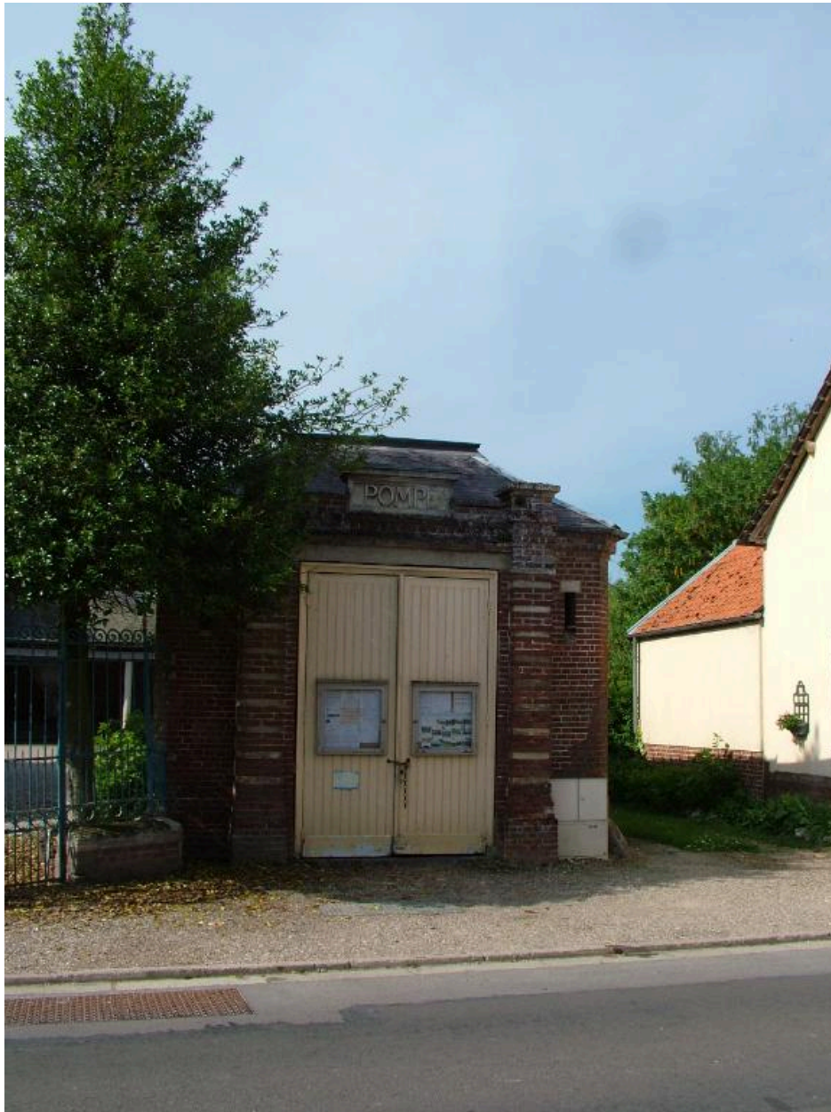
La remise de la pompe à incendie.
