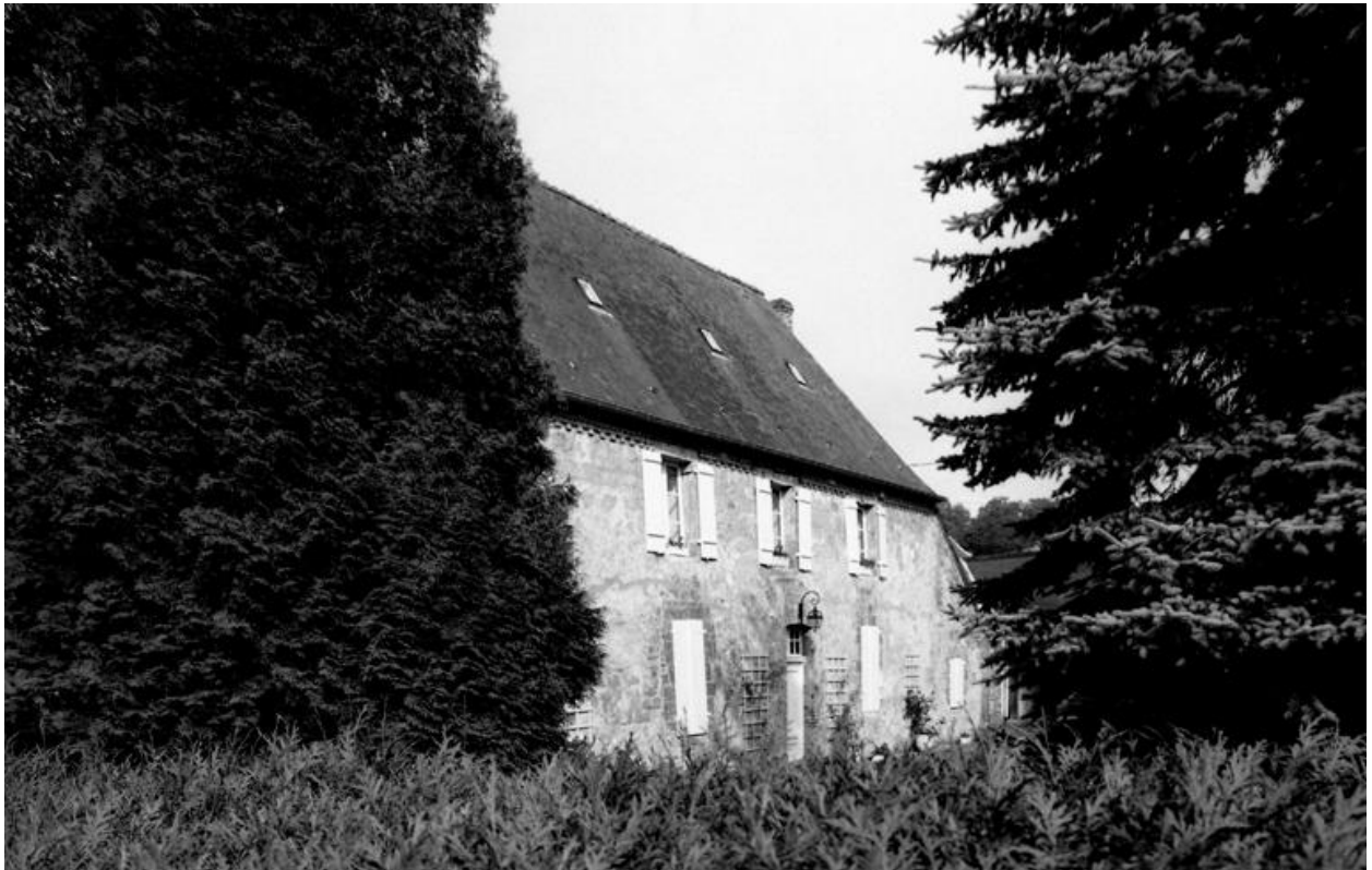
Vue partielle de l'élévation arrière du logis prioral.
