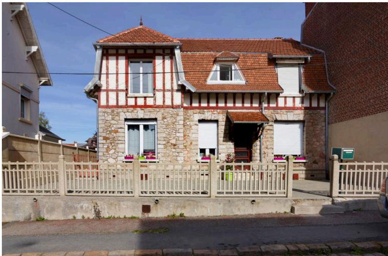
Maison, n° 14 rue Jean-Baptiste-Lequette. Façade sur rue. Ancienne maison de M. François Théry, construite en 1928 par Eugène Rousseau. Maison en retrait par rapport à la rue et décorée au premier niveau d'un faux pans de bois.
