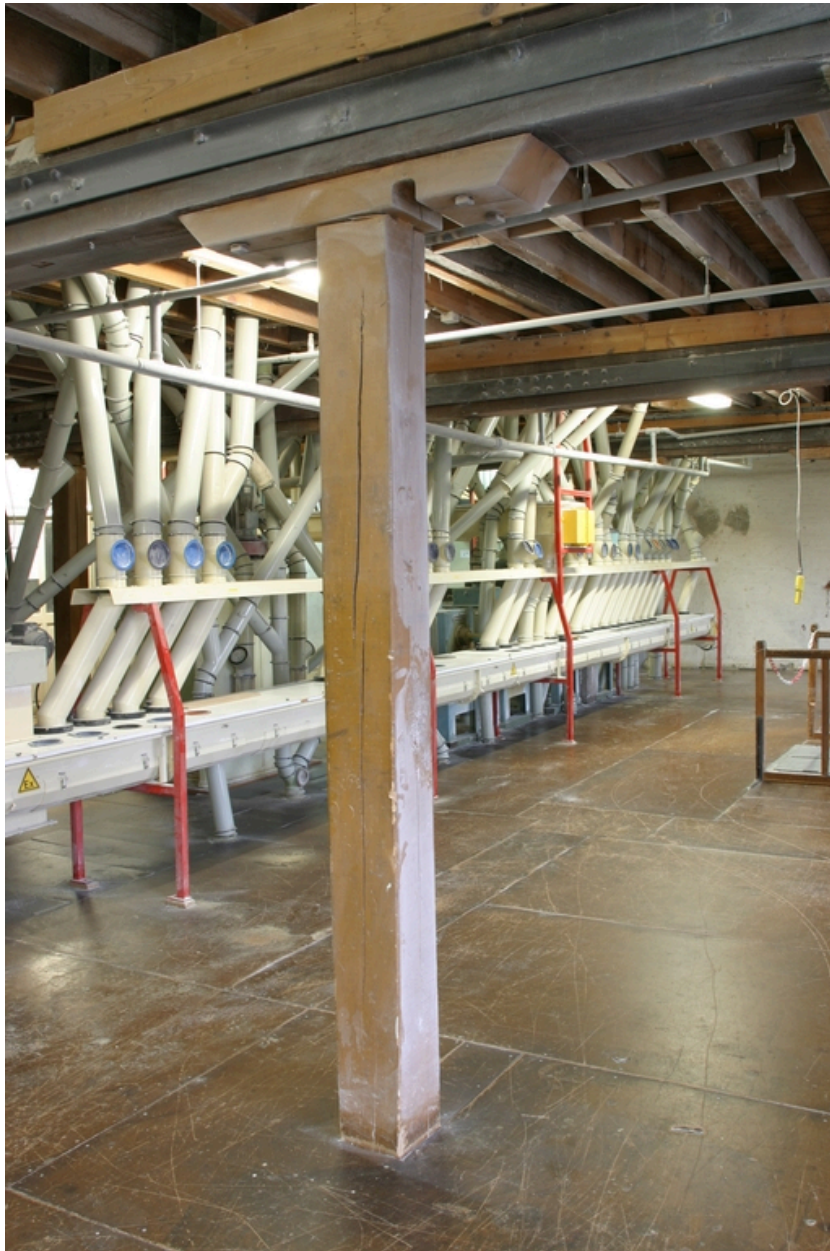
Troisième étage de la minoterie.
