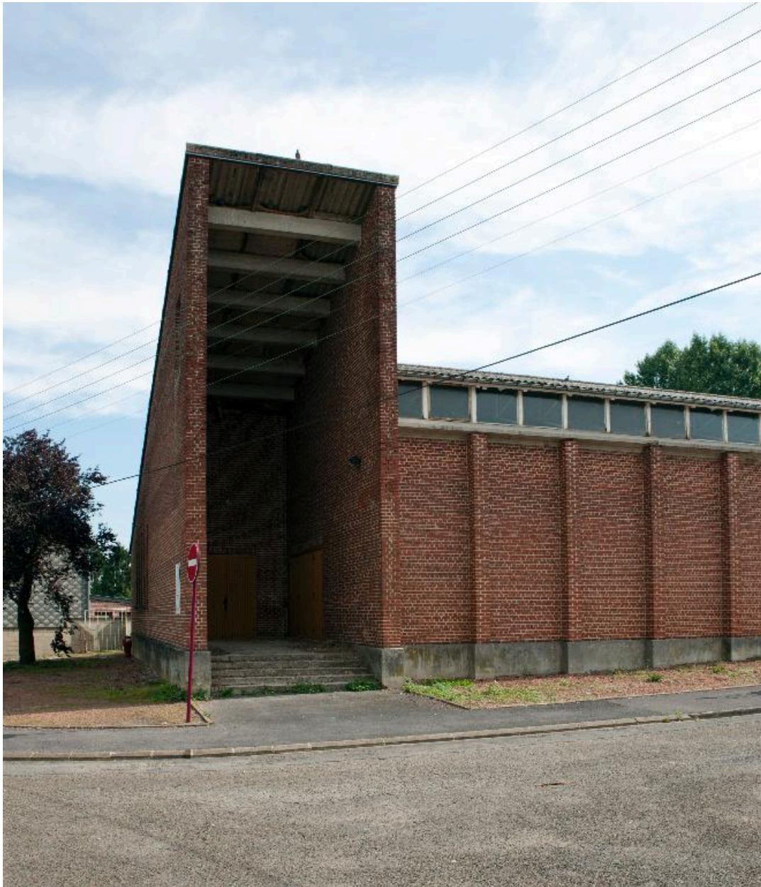
Détail de l'entrée.
