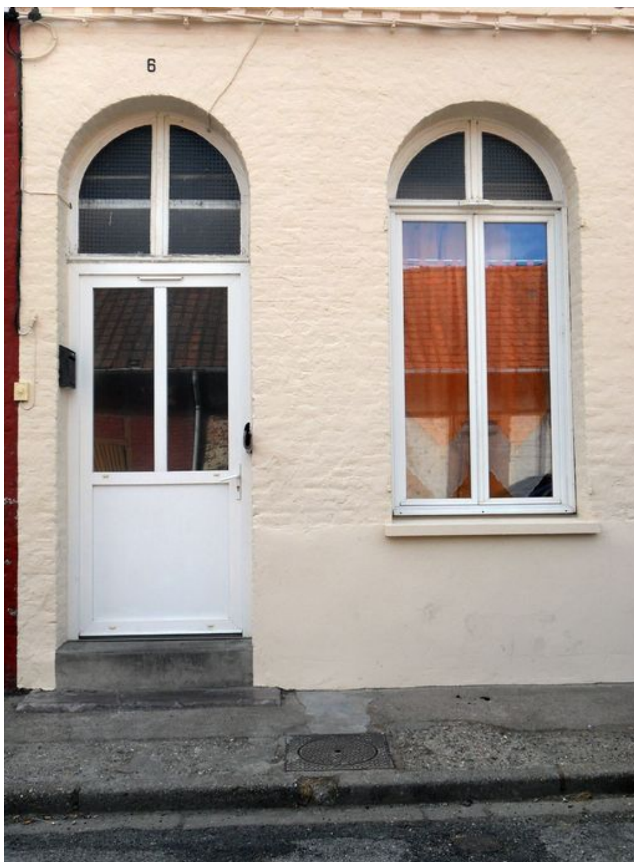
Logement, 6 rue Saint-Jules : détail de la façade.
