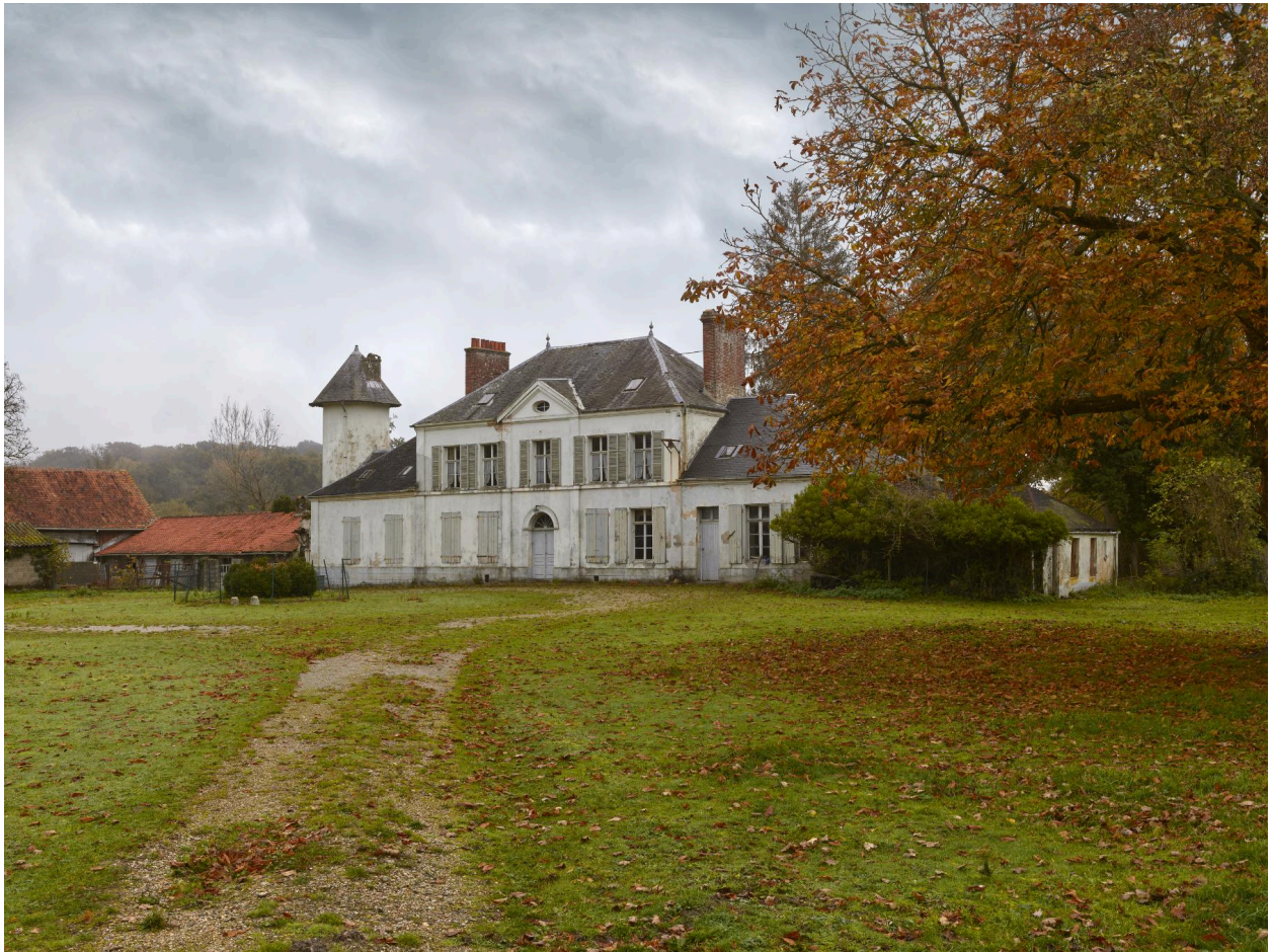
Vue générale du château du Moulinel prise depuis le nord-ouest
