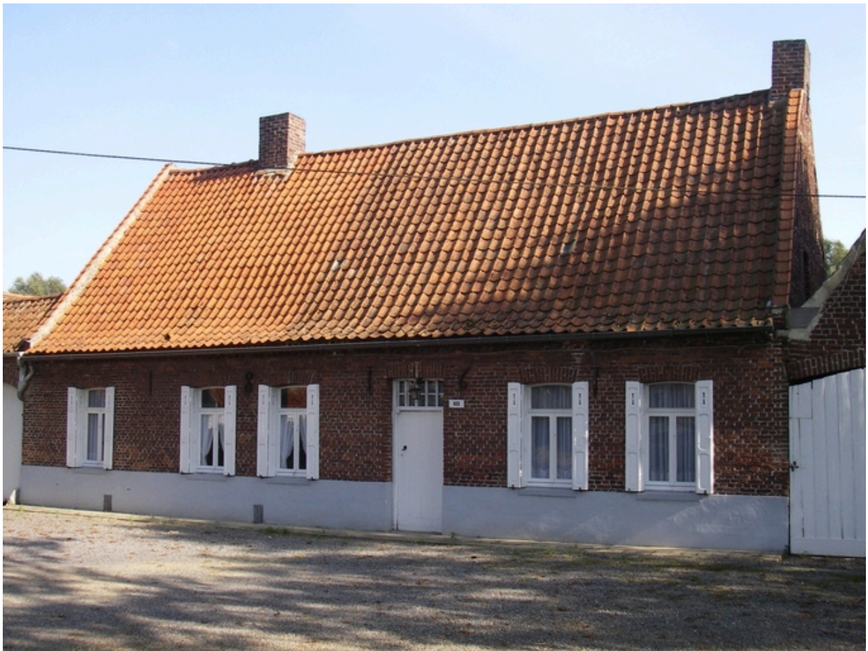
Logis de la ferme, 348, rue Stanislas-Machynia, vue depuis la rue.
