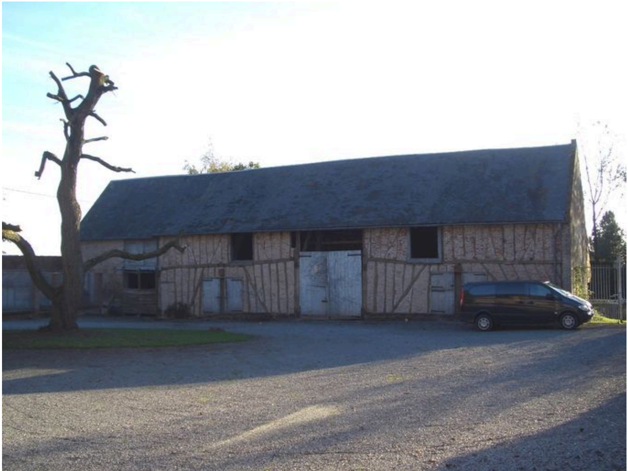
Vue de la grange au sud.
