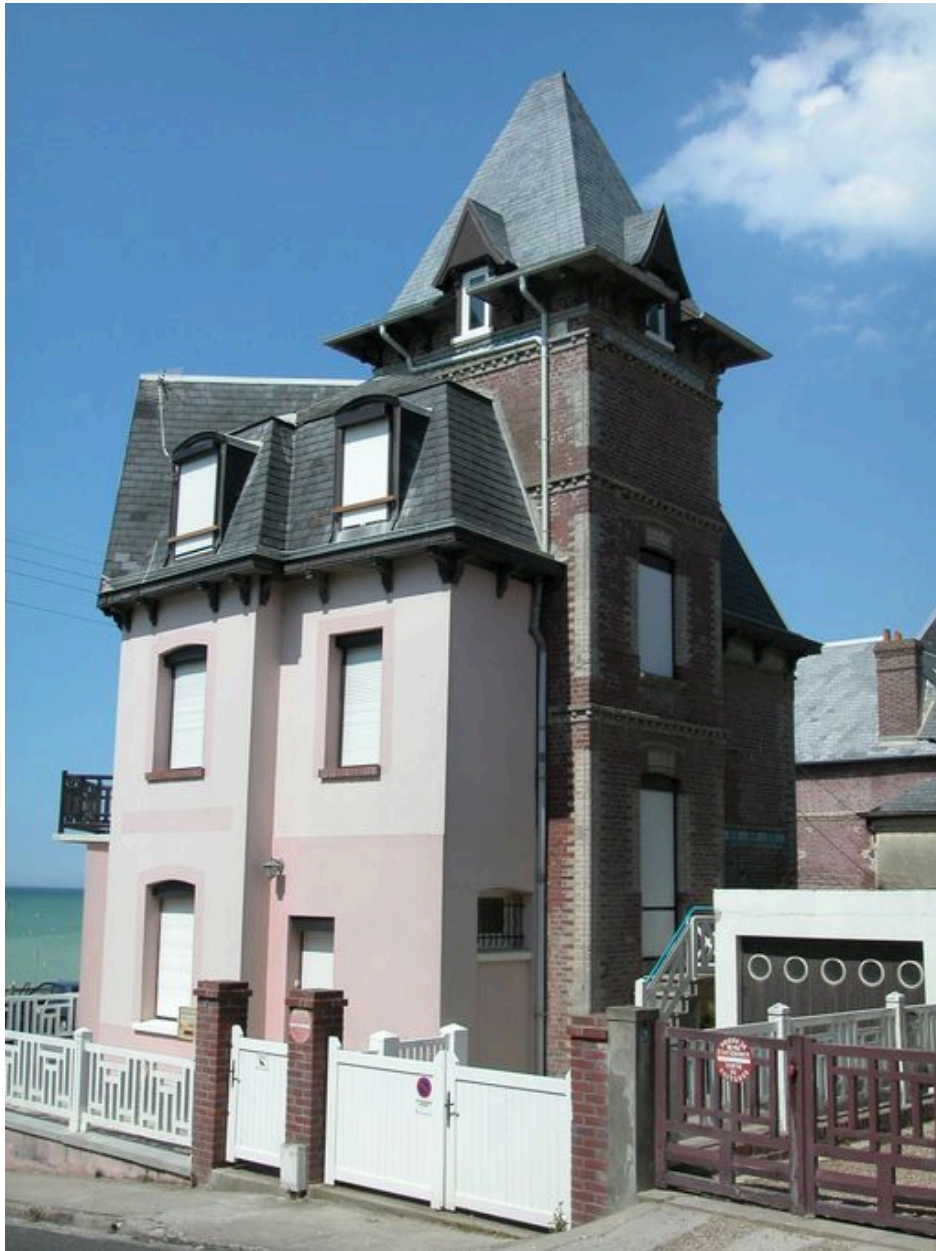
Vue de trois-quarts depuis l'avenue du Casino.
