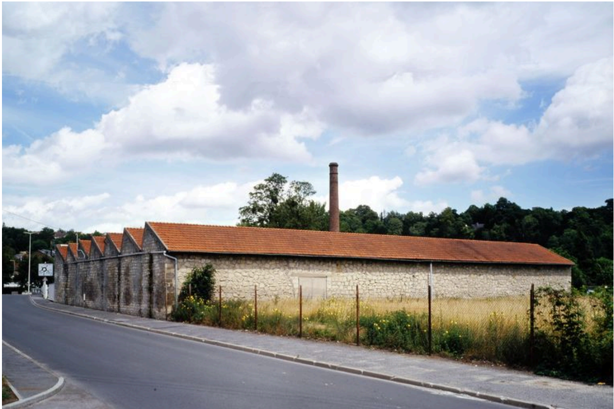
Ateliers couverts de sheds en dents de scie de l'usine de lacets.
