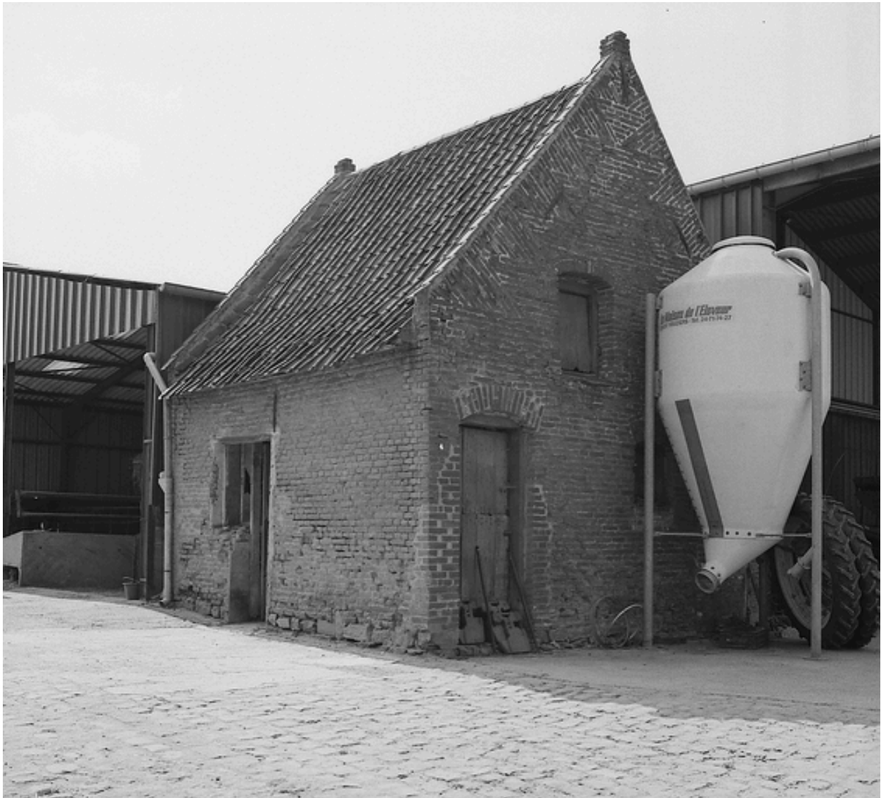
Vue générale du fournil.
