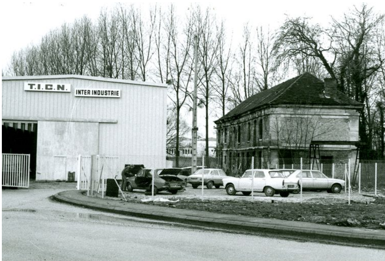
Usine III : Bâtiment dépendant du moulin du château et nouvelles constructions en 1977 (AC Villers-Saint-Paul ; non coté).
