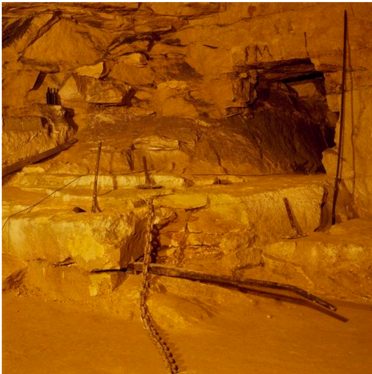
Chantier de taille et ses outils : aiguille, barre à looper, treuil et scie.
