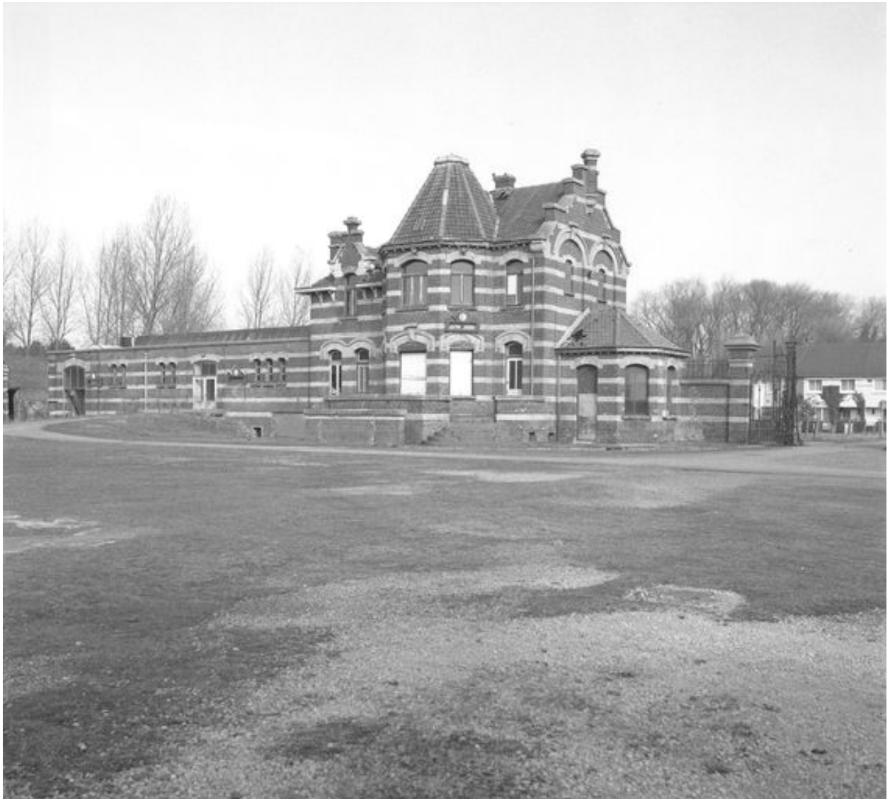
Habitation du chef d'élevage, vue d'ensemble sur cour en 2003.
