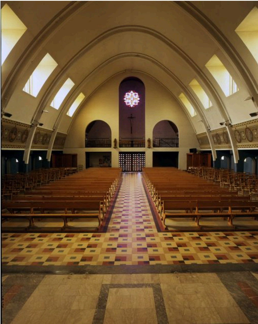
Vue d'ensemble de la nef et des bas-côtés.
