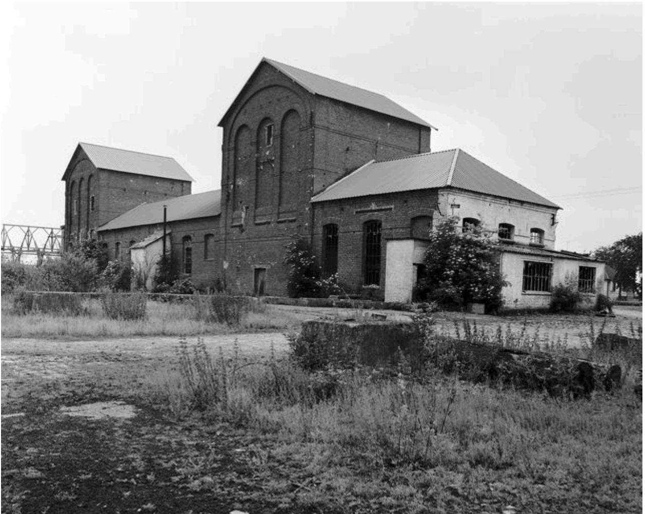
Façade postérieure de la distillerie de 1880, vue de trois-quarts (nord-est).
