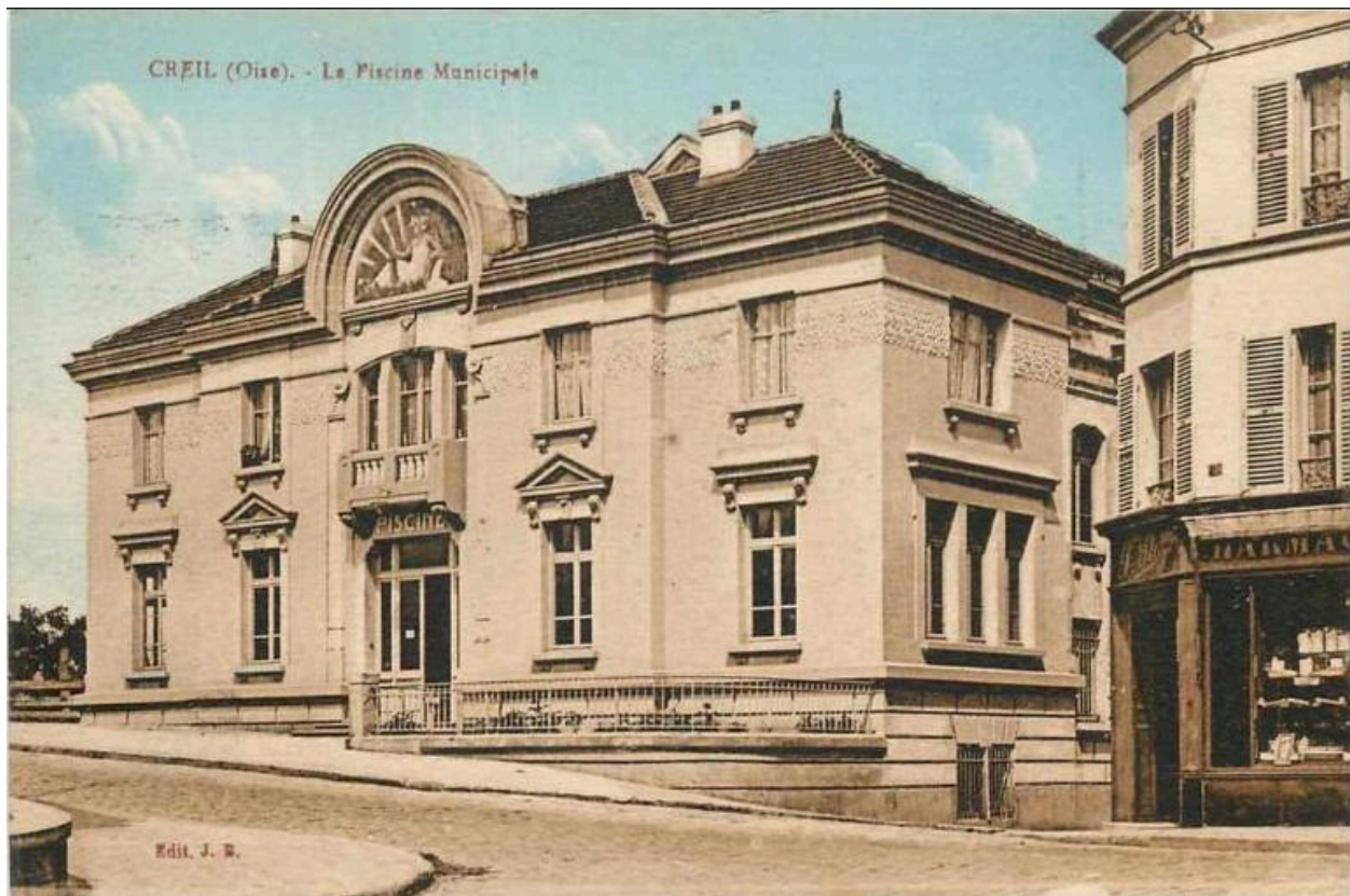
Façade de la piscine de Creil en 1926, carte postale, vers 1930 (coll. part.).
