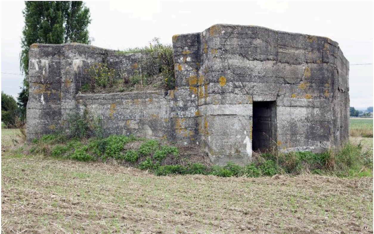
Vue de trois-quarts avant, vers le sud
