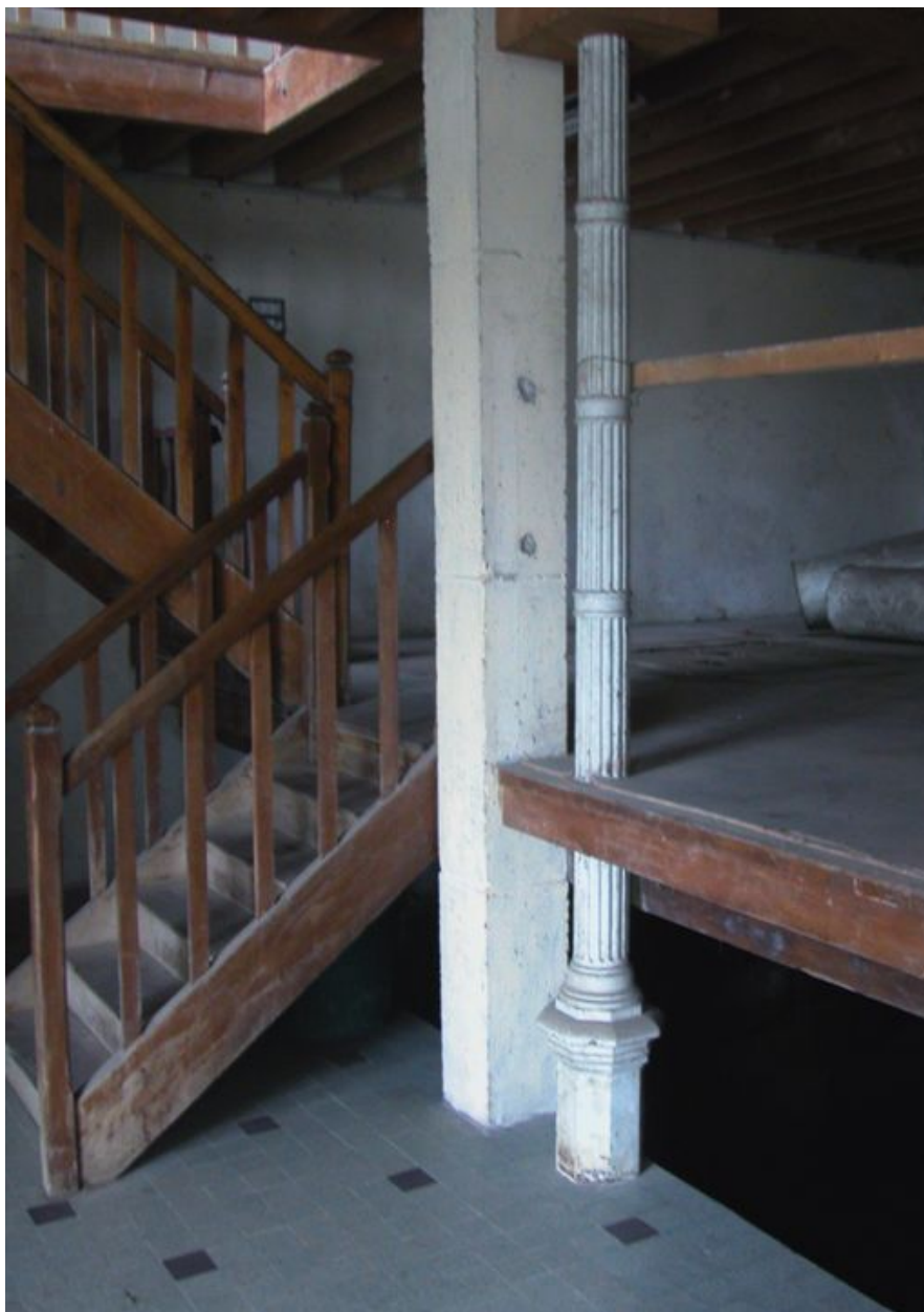
Détail d'une colonne cannelée en fonte, rez-de-chaussée.
