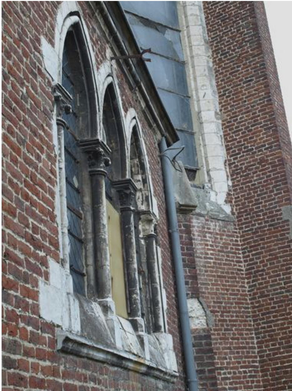
Fenêtre de la sacristie et mur de l'abside
