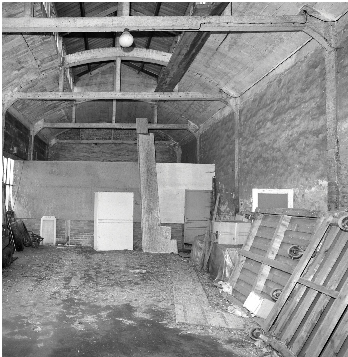
Vue intérieure du hangar.
