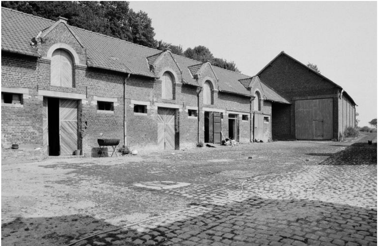
Vue de l'étable et de la grange, depuis le nord-ouest.
