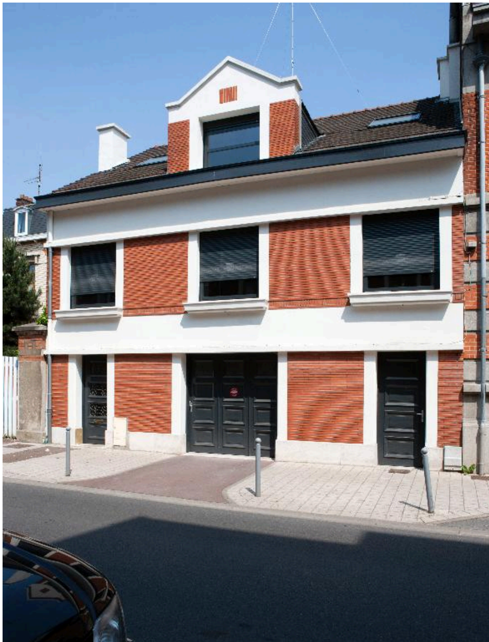
Maison construite dans les années 1940-50, rue Mathieu-Dumoulin.
