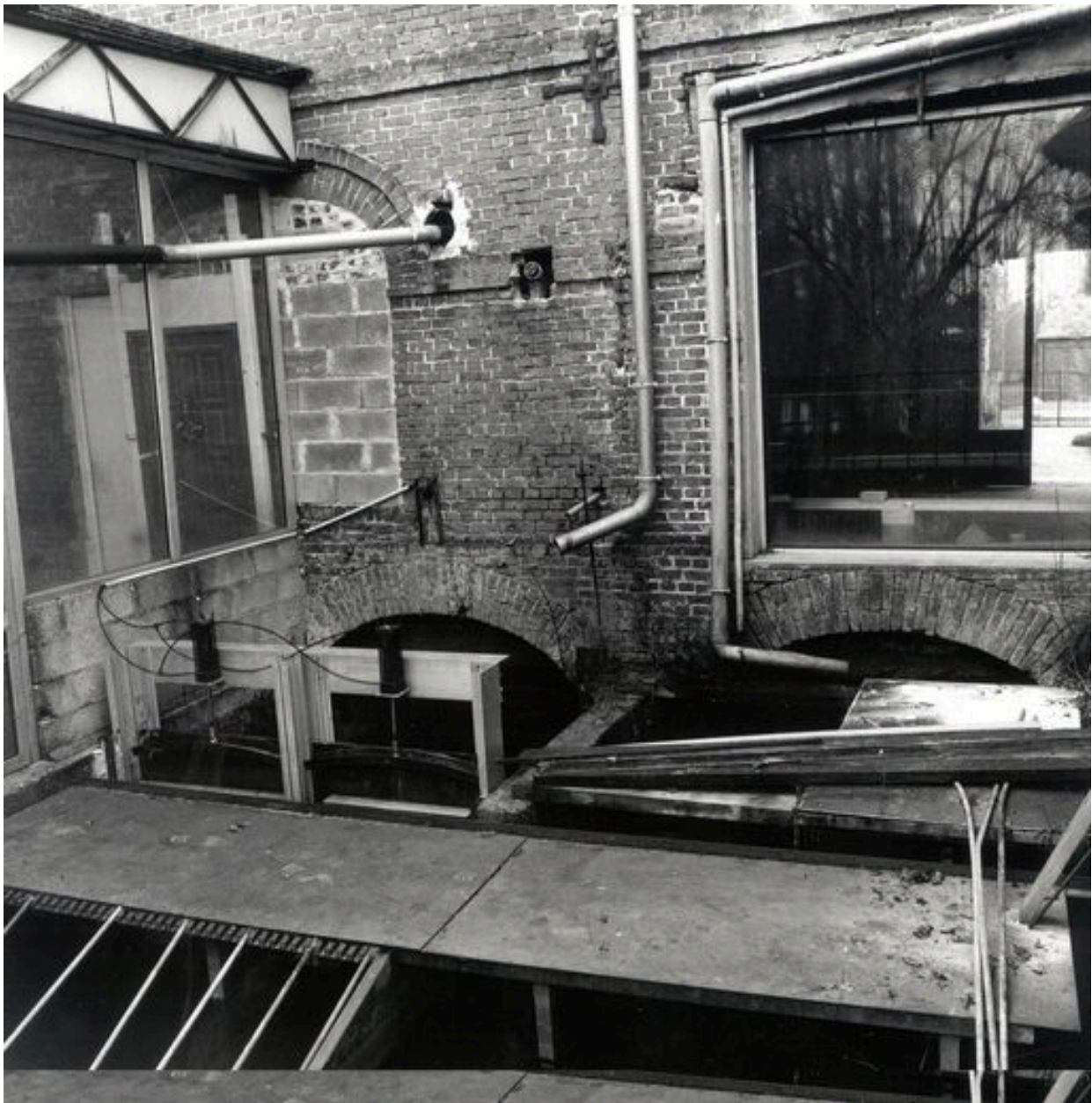
Détail de la double coulerie maçonnerie.
