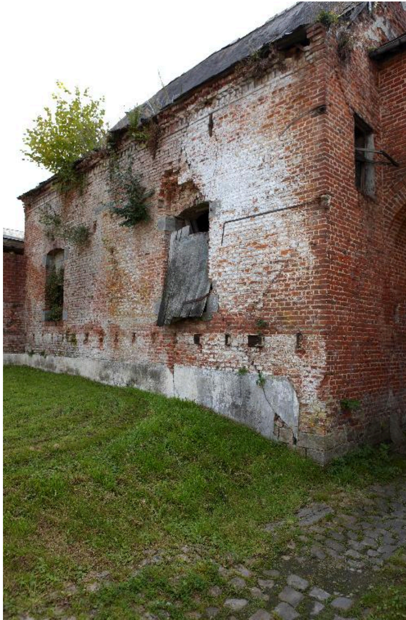
Elévation sur rue de l'ancienne salle des cuves.
