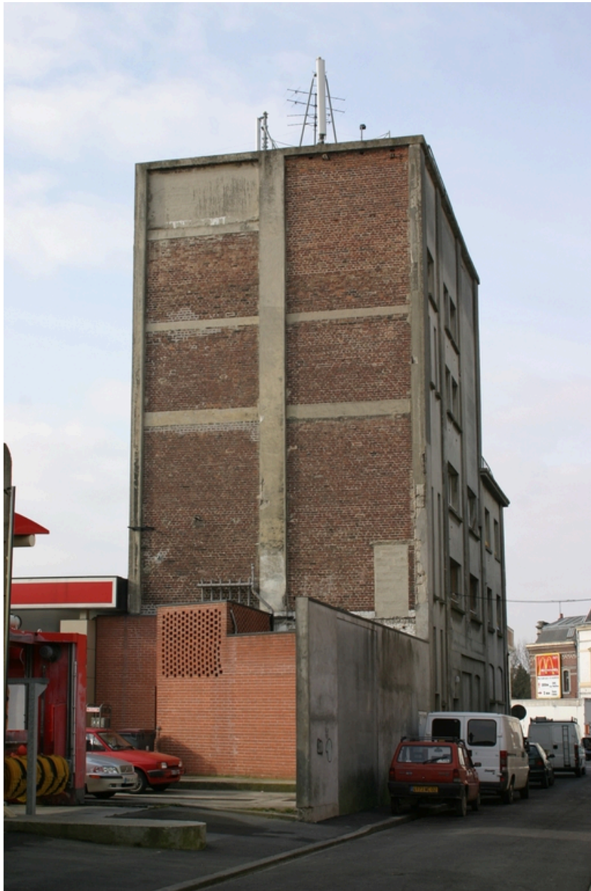
Les vestiges de la brasserie vus depuis la rue Blanqui.
