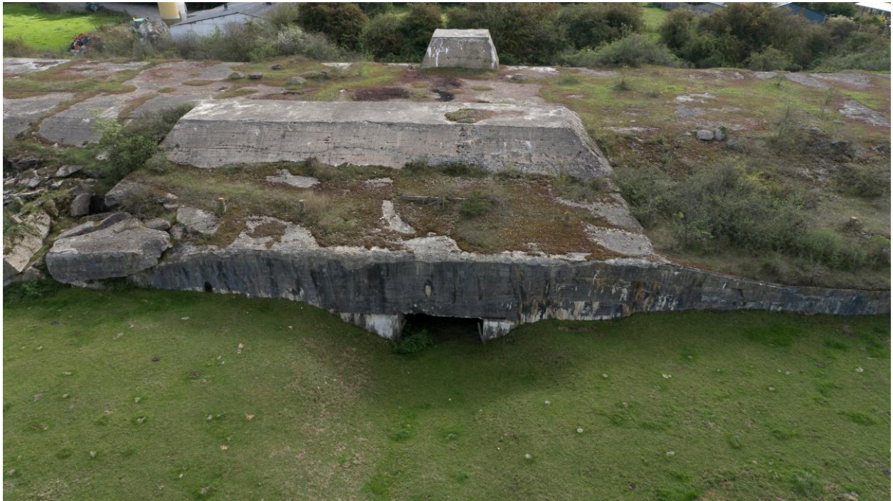
Vue aérienne de l'élévation nord-ouest. Détail de la sortie de la rampe de catapultage.
