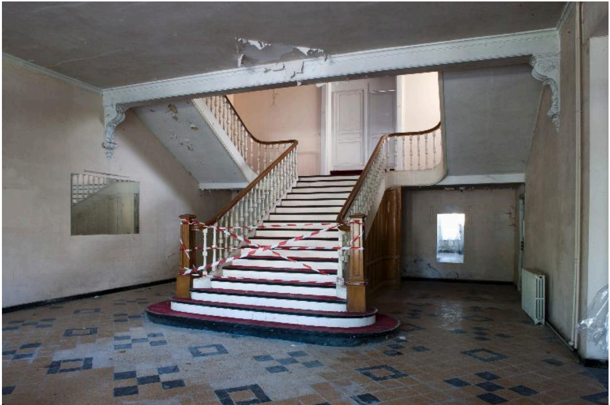
Le Grand escalier de l'hôtel, état en 2012, avant réhabilitation.
