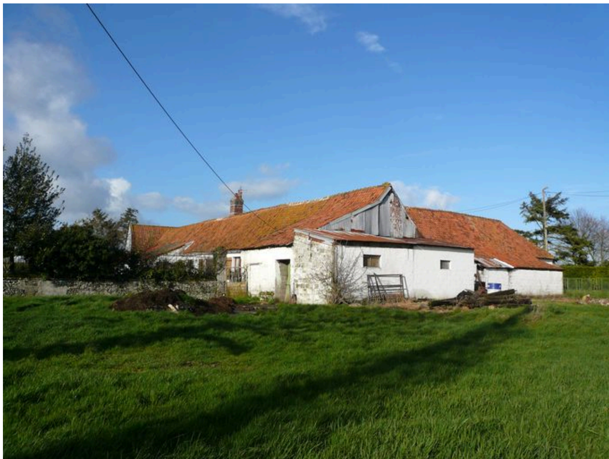
Vue générale postérieure.
