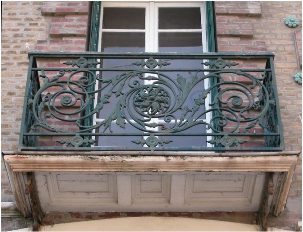
Détail du décor de fonte du garde-corps des balcons des étages-carrés.
