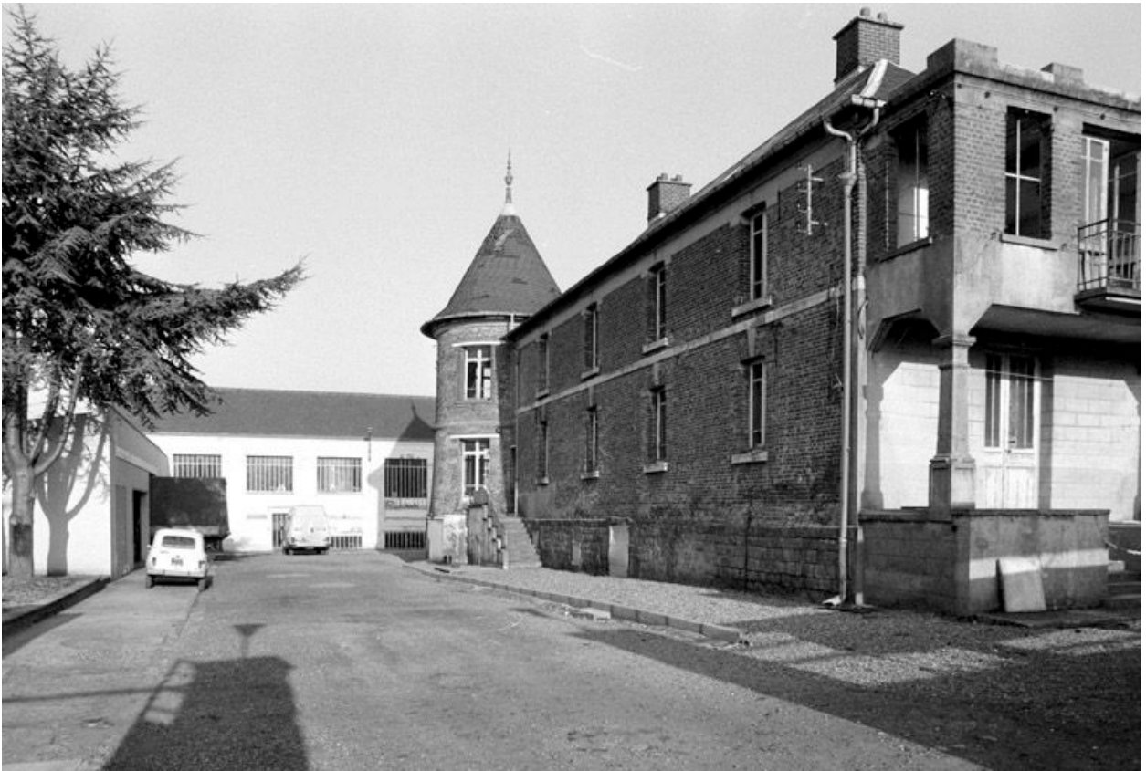
Bureau et logement patronal.
