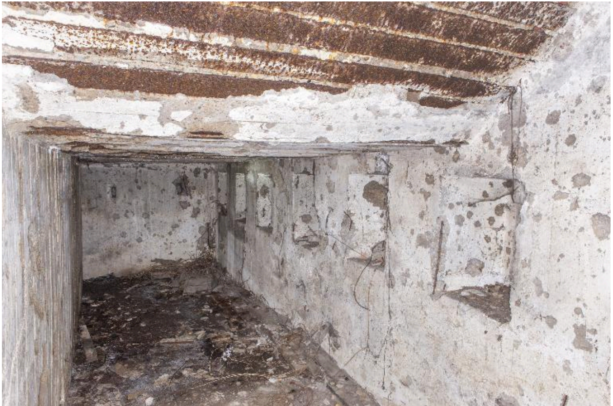
Créneaux de fusillade depuis le premier niveau de l'édifice vers le niveau intermédiaire
