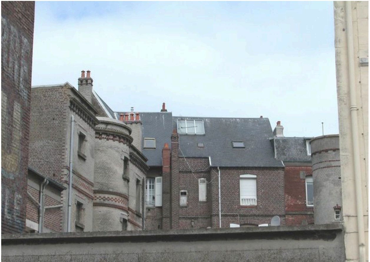
Vue de la façade postérieure depuis l'avenue du Maréchal-Foch.
