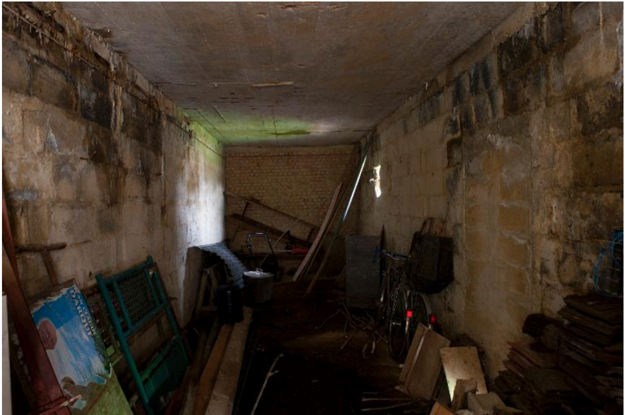
Bâtiment de stockage d'attente. Vue intérieure.
