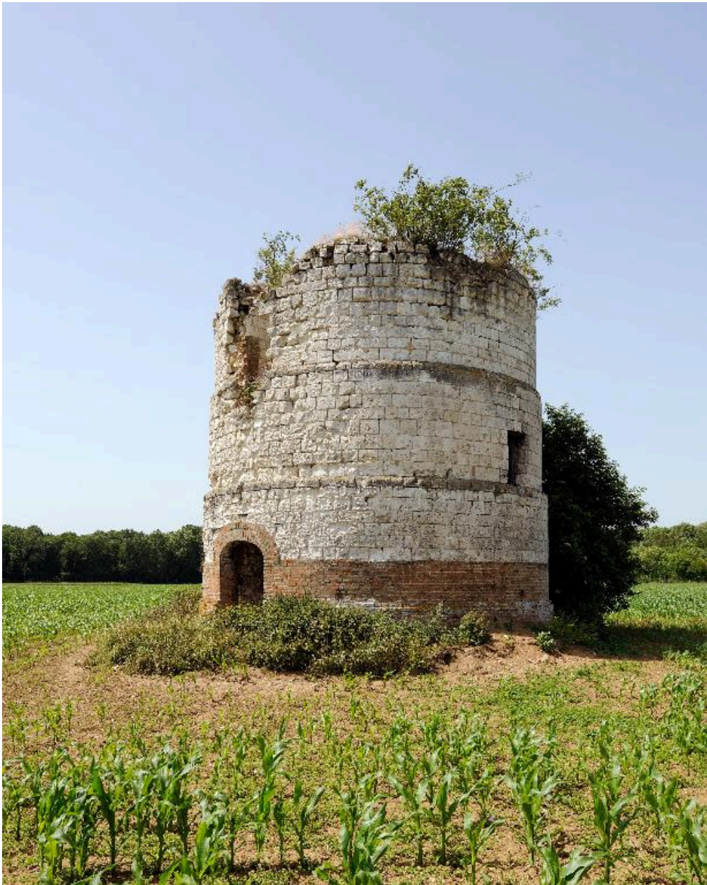
Vue générale depuis l'est.
