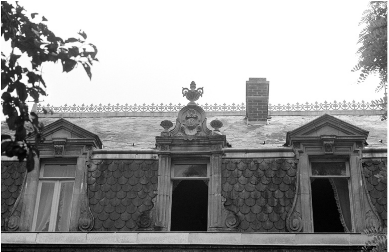
Détail de l'élévation antérieure : le toit brisé.
