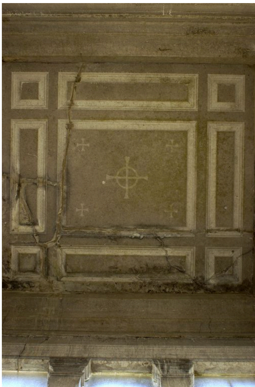
Vue intérieure, détail sur le plafond.
