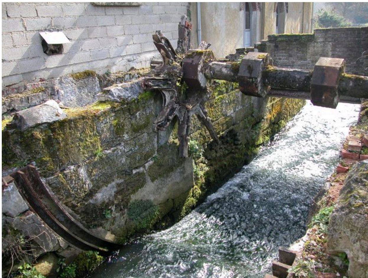
La coulerie du moulin avec les vestiges de la vanne plongeante incurvée et de la roue hydraulique.
