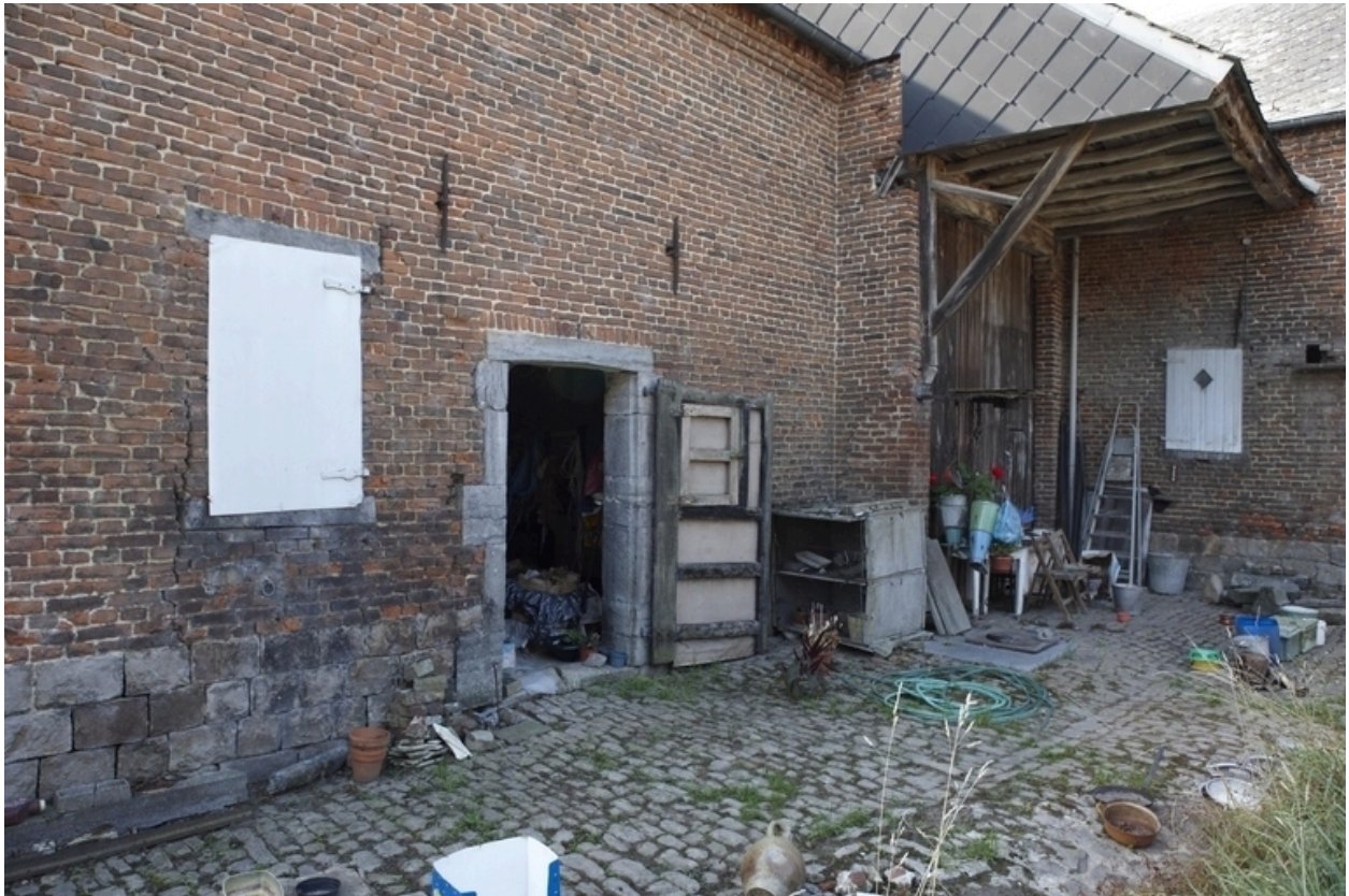
Vue de l'auvent de la grange.
