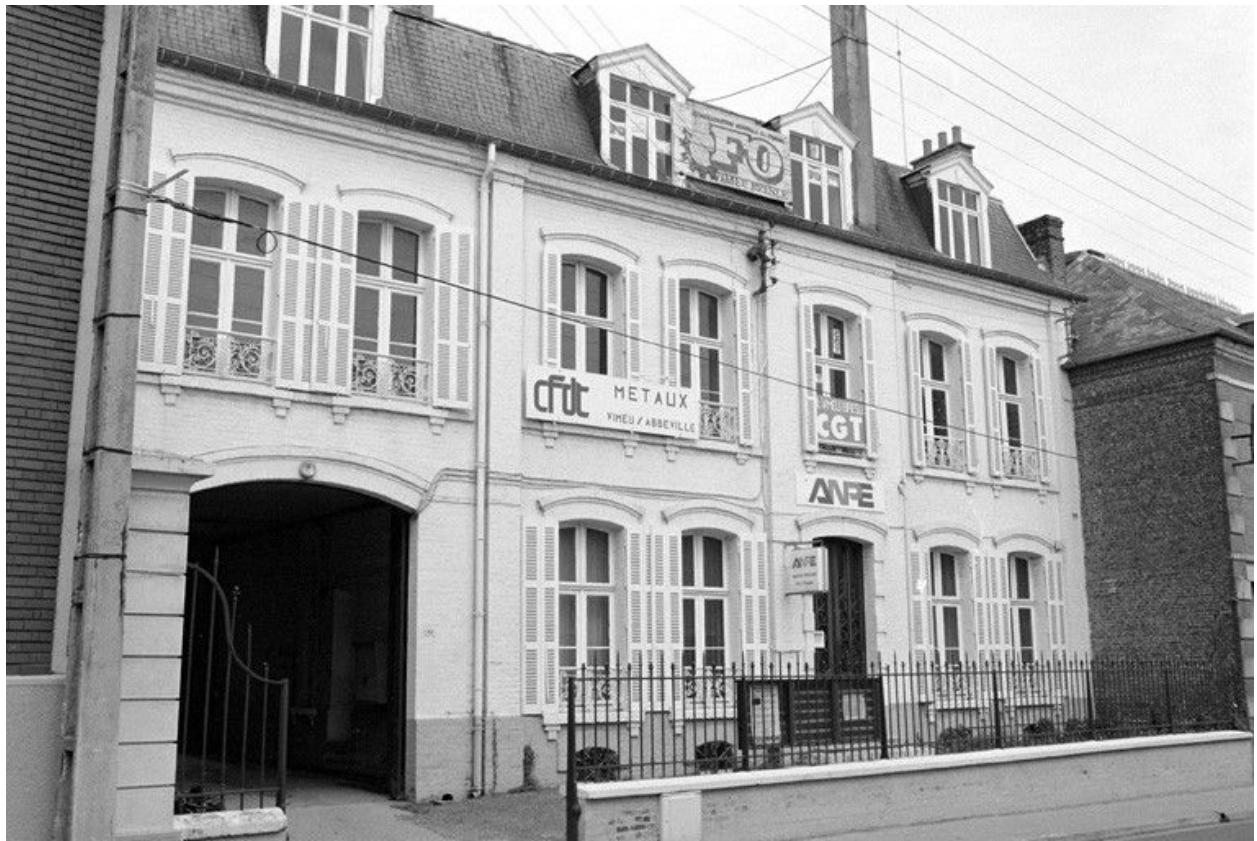
Logement patronal n°1, élévation antérieure, en 1990.
