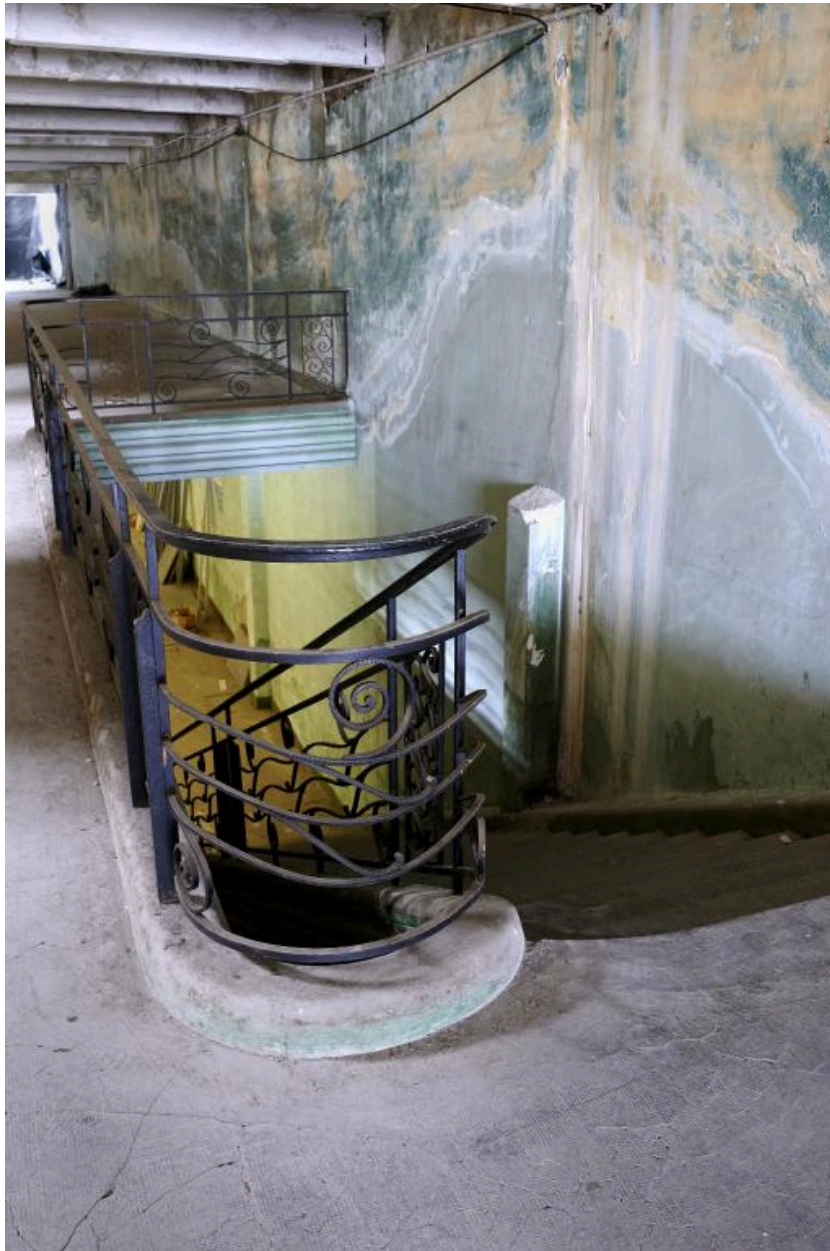
Rampe d'escalier du dernier niveau.
