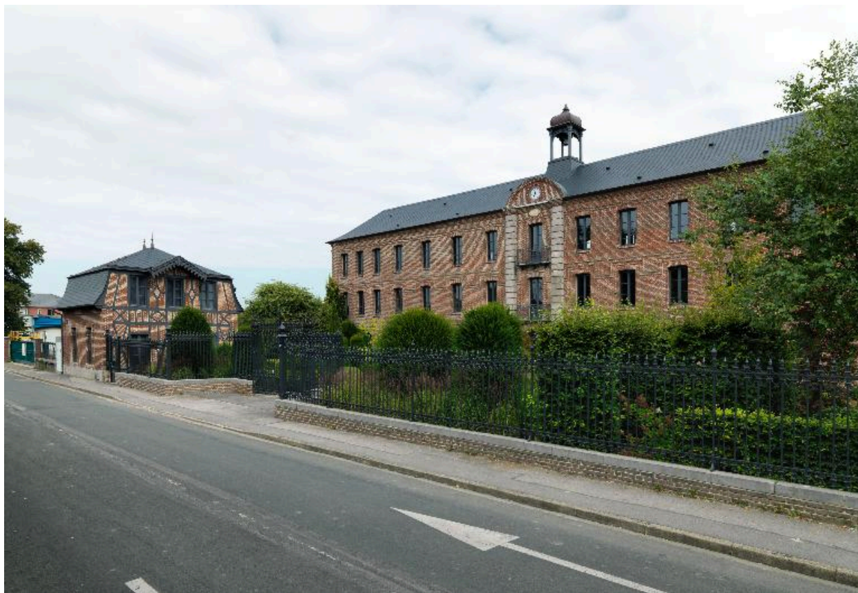
Vue d'ensemble de la conciergerie et des anciens ateliers de l'usine Laperche.
