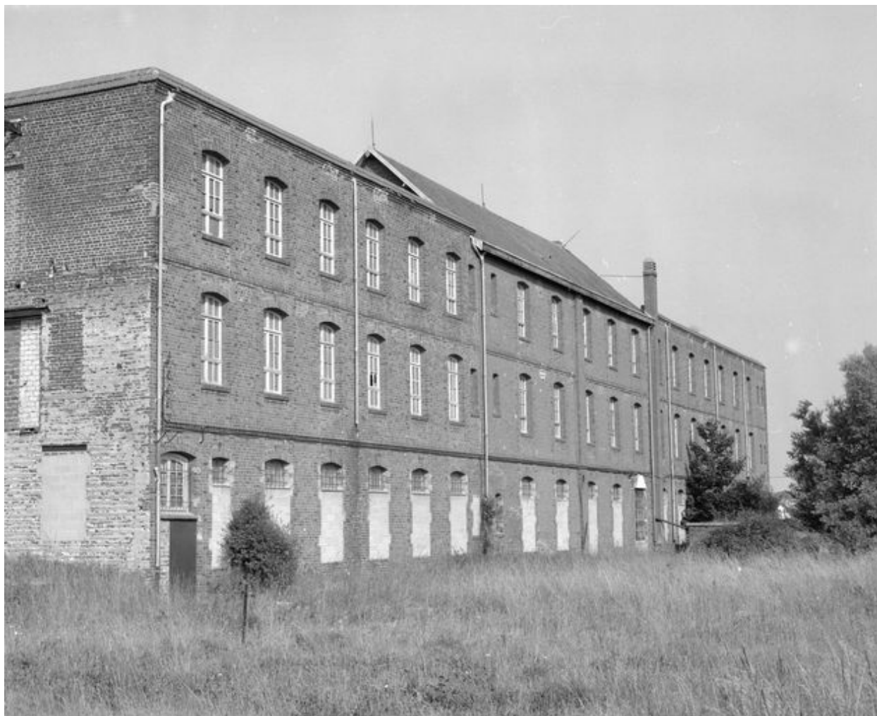
Corps de logis principal, élévation postérieure, vue de trois-quarts gauche.
