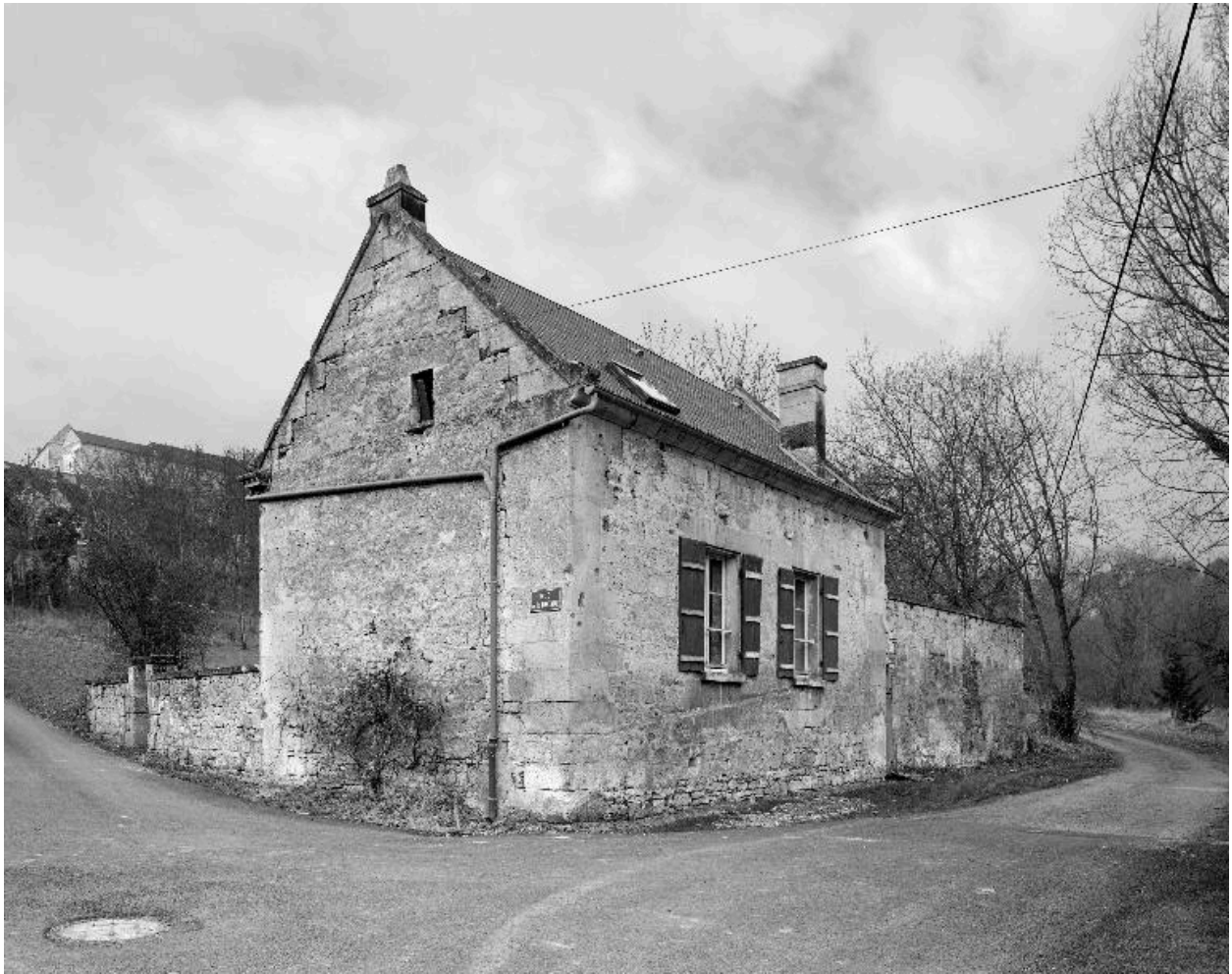
Vue d'ensemble de la maison, depuis l'est.
