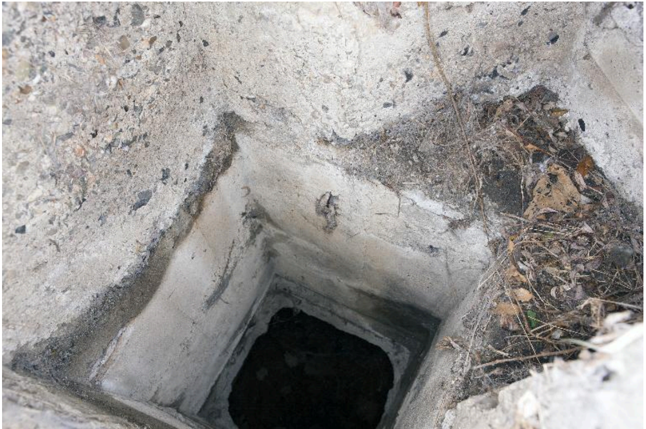
Intérieur de la tour de communication optique, vers le bas
