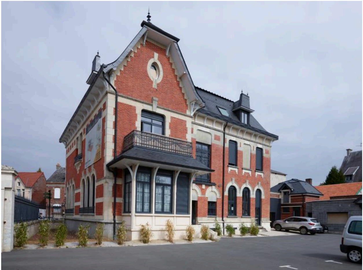
Façade sur cour.
