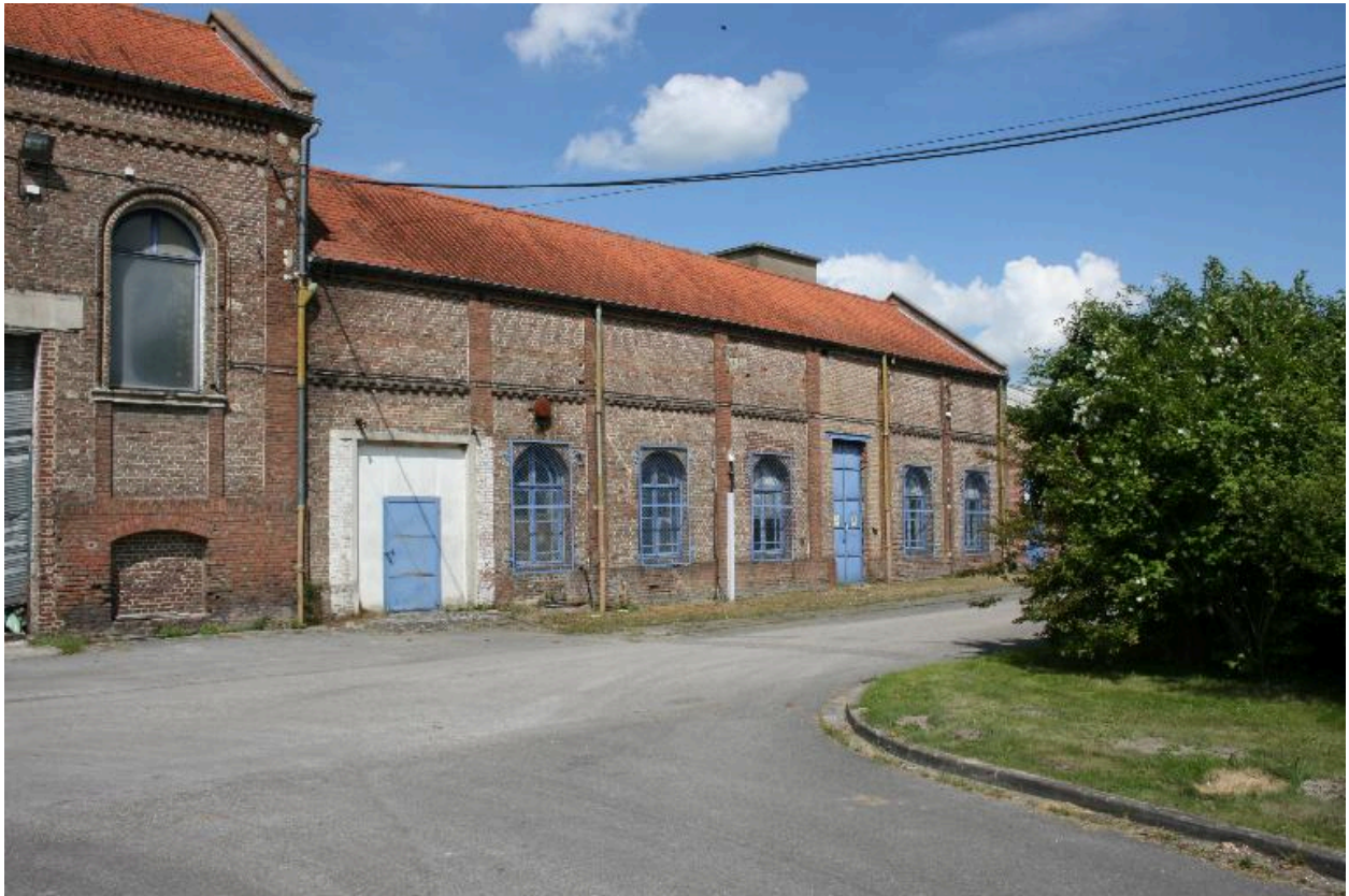
Façade sud du magasin à fil.
