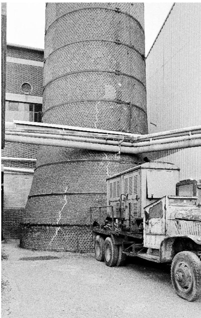
Cheminée d'usine, base.
